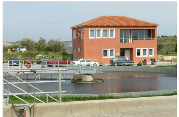
Δευτεροβάθμια καθίζηση και κτίριο διοίκησης στη ΜΕΛ Μυτιλήνης
